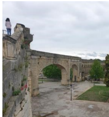
Aqueduc moderne de Montpellier
